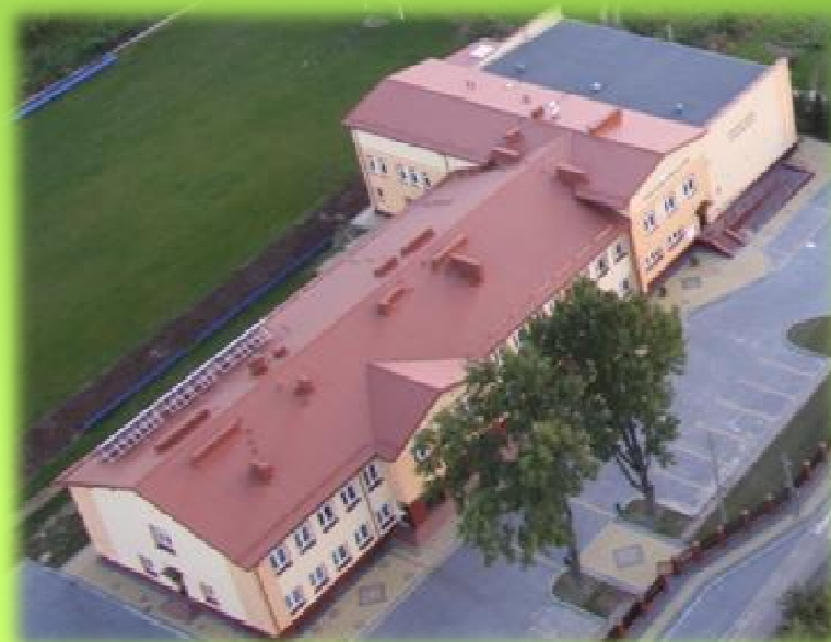
Budynek Zespołu Szkół w Przesmykach w 2011r
