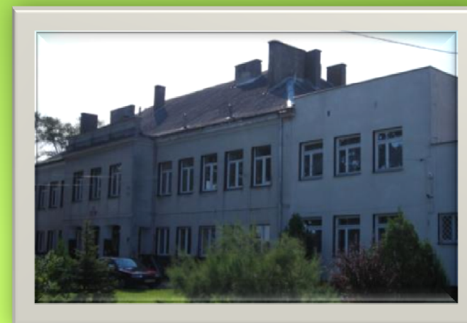
Budynek Zespołu Szkół w Przesmykach w 2005 r.
